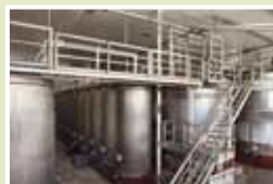
Passerelle avec garde-corps, accès escalier avec rambarde
